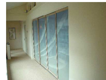
バラート+デザインシート貼り
